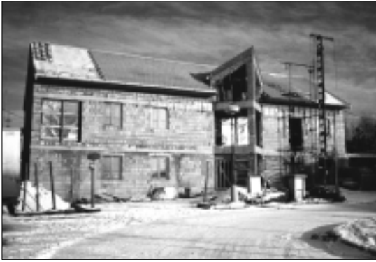
Vánoce 1996 – dům máme pod střechou (skoro).
