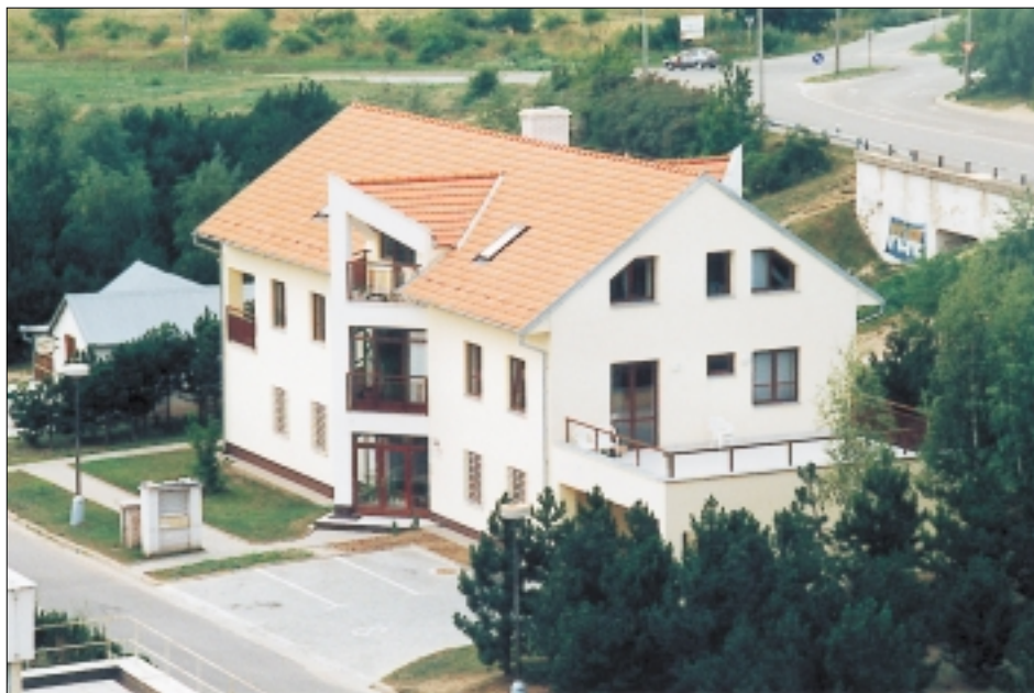
Budova TWR-CZ v Brně - Líšni.
