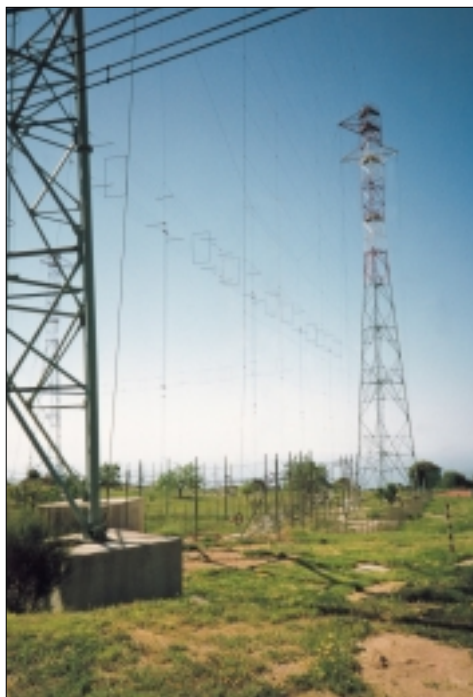
Systém KV antén vysílače Monte Carlo. Antény jsou směřovány do určitých oblastí. Celý systém umožňuje vysílat v mnoha jazycích a do různých směrů současně.
