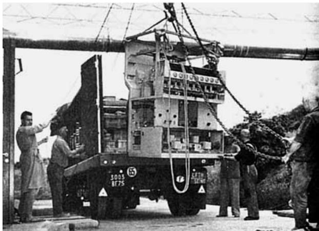
Dobová fotografie z instalace jednoho z přístrojů vysílače... něco jako zesilovač.
