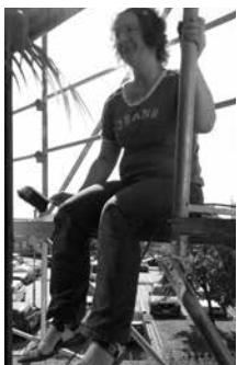
Jitka Vyležiková v akci - spolu s Vlastimilem a Ludkem využili lešení a oškrábali a ošetřili okna na opravované straně fasády.
