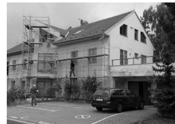
Probíhající oprava fasády.
