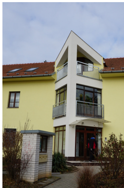
▲ Finální práce na dokončení fasády – návrat rohůžky před vchodem na původní místo
