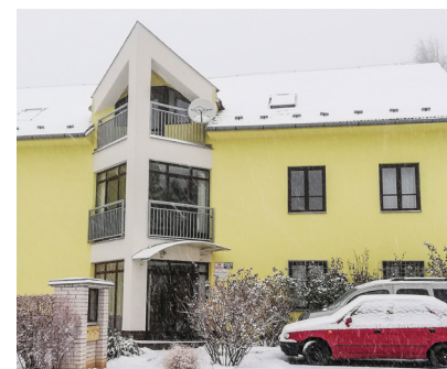
▲ Sněhu letos mnoho nebylo; o to více jsme se radovali, jak krásně čistě září do bílého dne opravená fasáda naší budovy. Děkujeme za vaši podporu.
