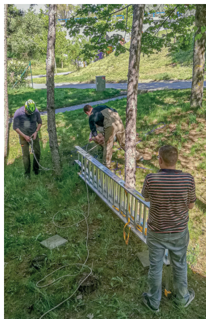
▲ Součástí sanitárního dne jsou pravidelně i výškové práce spojené s čištěním okapů
