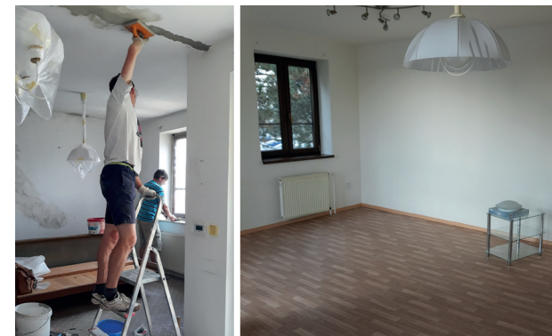
▲ S rekonstrukcí bytu v budově rádia pomáhali i synové Ludka Brdečko .
